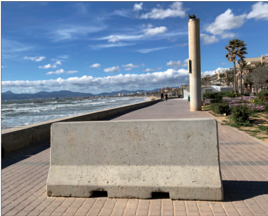
Schutz vor Terrorattacken mit Fahrzeugen: Betonbarriere auf der Playa de Palma.
