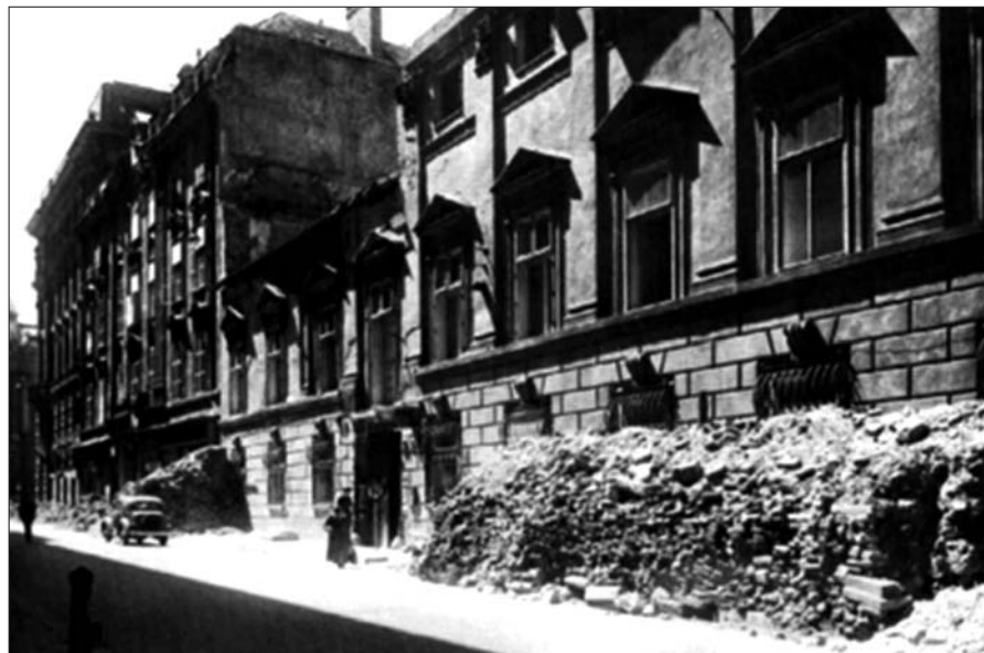
Das durch Bomben beschädigte Gebäude des Innenministerium im April 1945.
