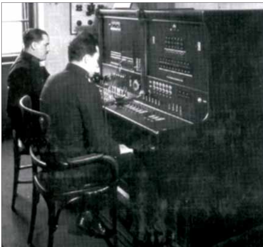
Erster Polizeinotruf A-I-22: Notrufschrank in der Telefonzentrale der Wiener Polizei im Jahr 1935.
