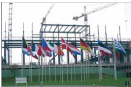
Umbauarbeiten am Palais des Gerichtshofs.
