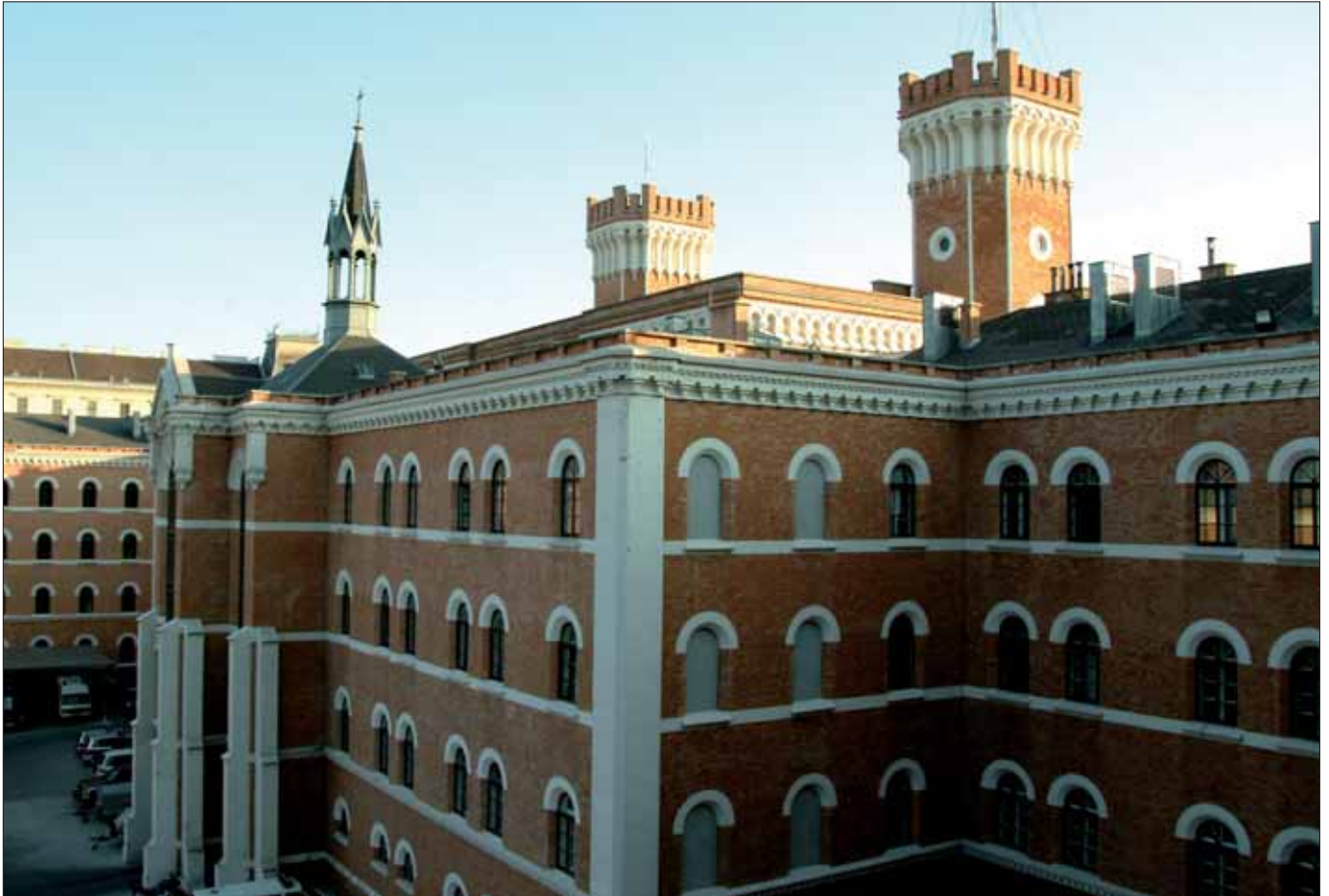
Rossauer Kaserne in Wien-Alsergrund: Baubeginn im Jahr 1864.
