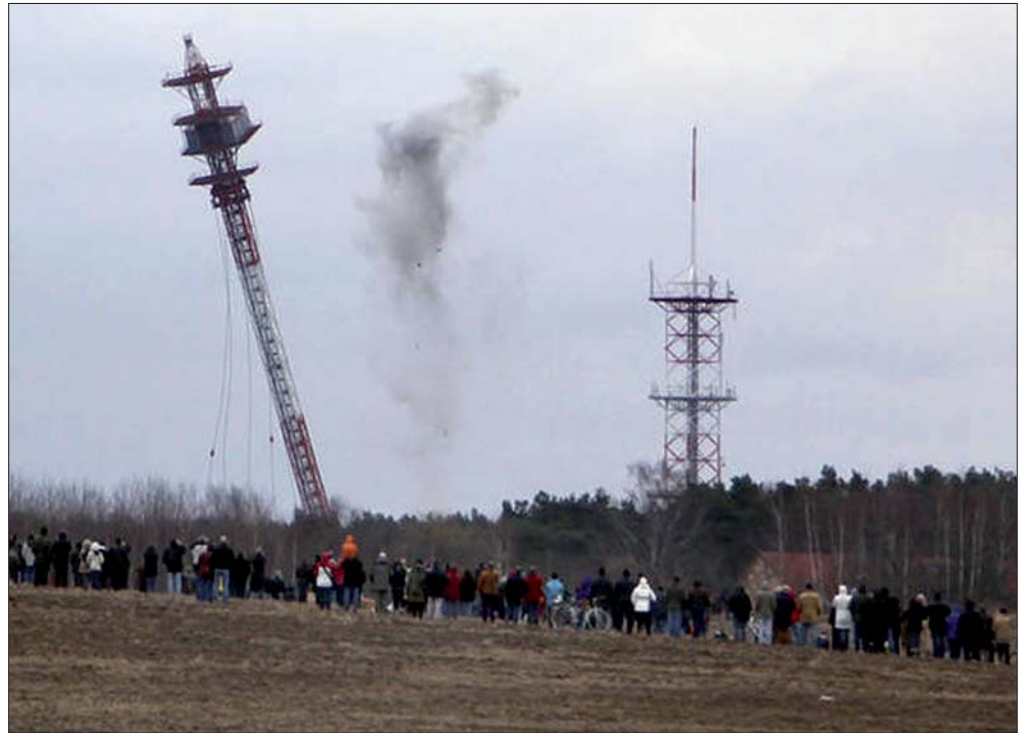
Sprengung des Sendemasts der Richtfunkanlage Berlin-Frohnau durch „Faltung“.
