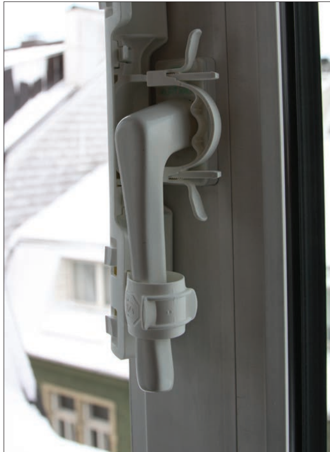
Fenstersicherung: Eine Schlaufe verhindert das unbeabsichtigte Öffnen des Fenstergriffs.
