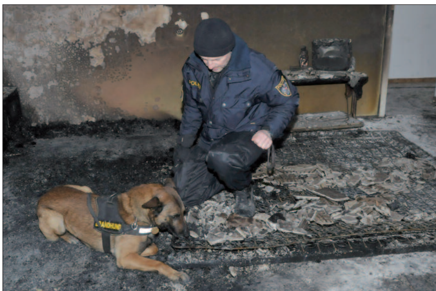
Brandursachenermittlung: Wichtig bei der Erhebung der Brandursache ist es, die Brandverlaufspuren zu erkennen und richtig zu interpretieren.
