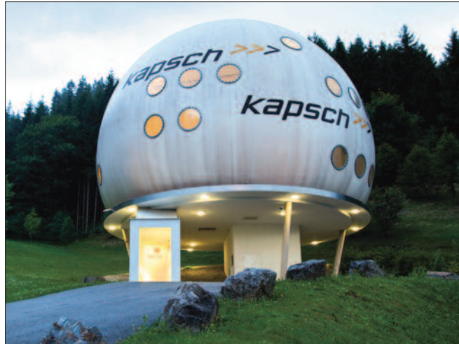
Kunden-Rechenzentrum von Kapsch in der Steiermark.
