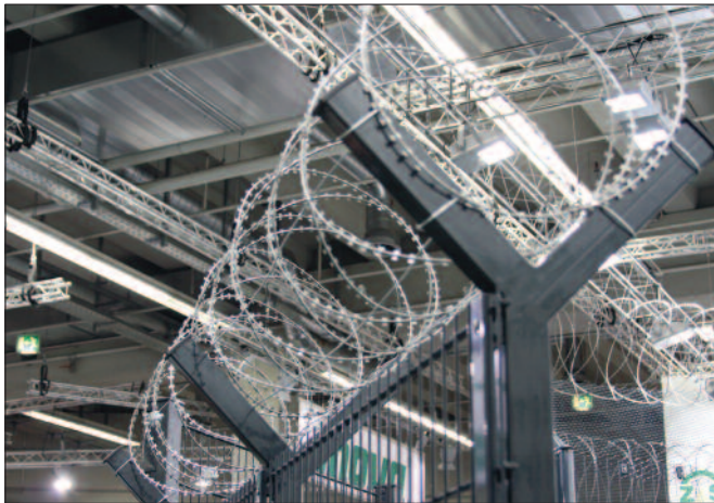
Wirksame Freigeländesicherung: Schutzzaun für Sicherheitsbereiche.
