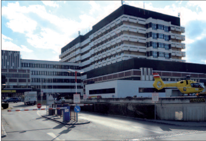
Krankenhäuser gehören zur kritischen Infrastruktur: 2016 erhielten einige Spitäler Drohungen.
