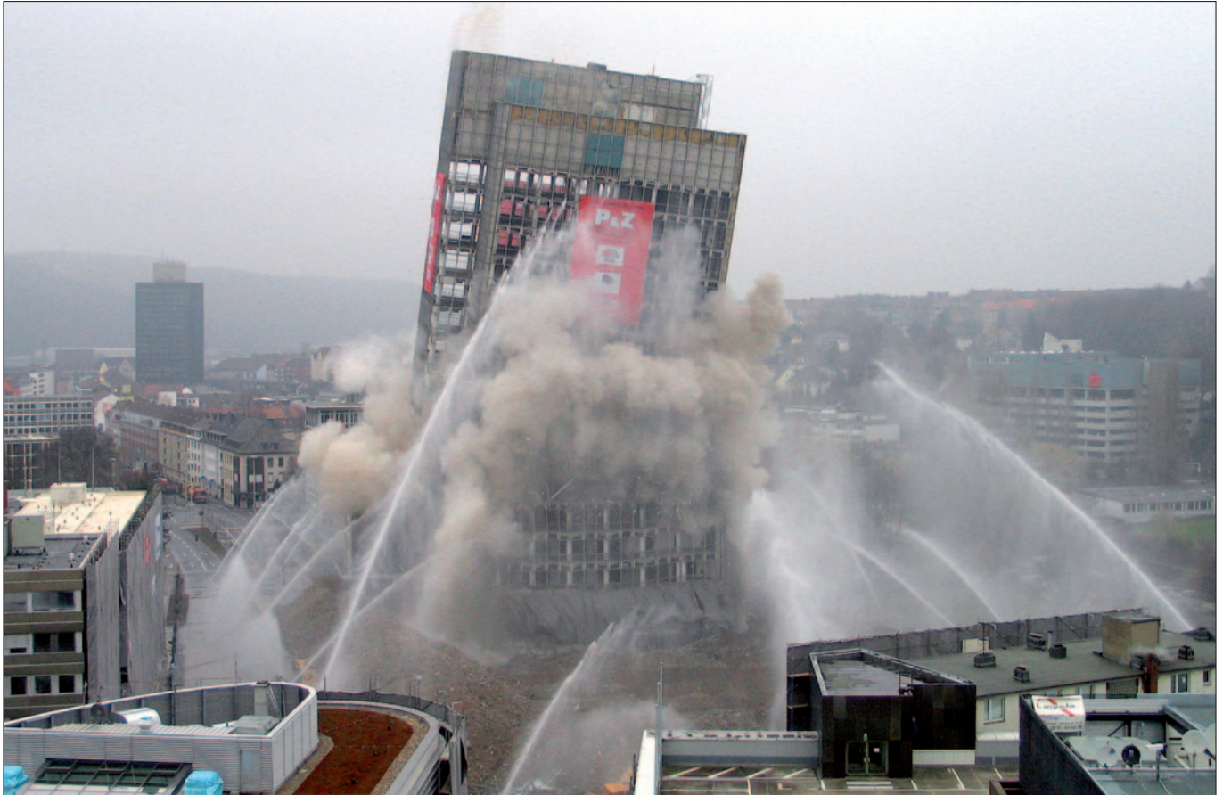
Sprengrung eines Sparkassengebäudes in der Hagener Innenstadt in Nordrhein-Westfalen: Bei der 50. internationalen Tagung für Sprengtechnik in Linz ging es um neue Sprengmittel und -methoden.
