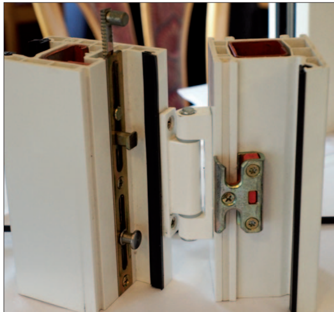
Einbruchsicherung: Pilzkopfverriegelung.
